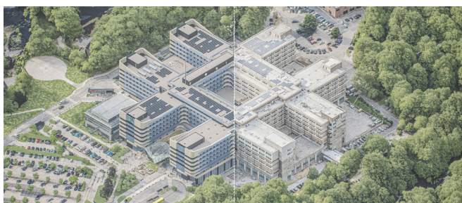
Rénovation des façades avant/après
