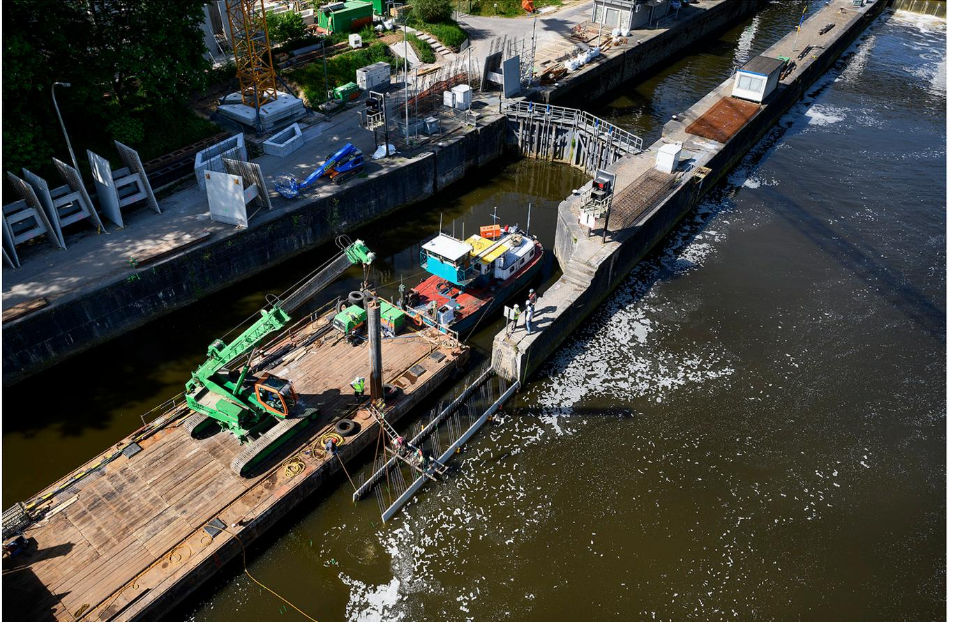
Le projet consiste à rénover l'écluse existante afin de mettre à gabarit CEMT VA l'ouvrage pour garantir le passage des bateaux de 110 m X 11.4 m, de 2000 t. Outre l'approfondissement de l'écluse, le chantier comprend également la rénovation des deux môles, le remplacement des deux portes busquées et des quatre vannes.
