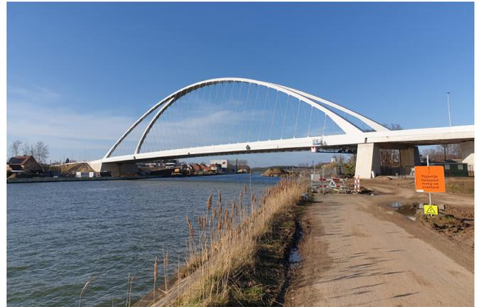
Dans le cadre de la mise au gabarit (hauteur 9,10m) pour la classe Vb du canal Albert entre Liège et Anvers, plusieurs ponts doivent être soit rehaussés, soit remplacés. Le remplacement de huit ponts a été confié dans le cadre d'un contrat DBFM.
