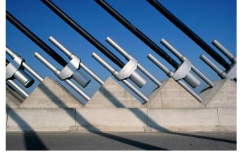
Pont haubané en béton à double nappe de haubans avec un seul pylône en Y renversé. La portée principale au-dessus du Canal Albert est de 177 m pour une longueur totale de l'ouvrage de 232 m, la travée d'équilibrage en rive droite et la culée contrepoids sont noyées dans les remblais de la rampe d'accès.
