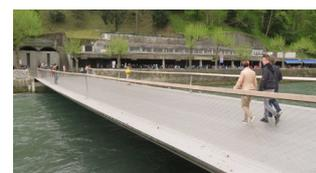
Cet encastrement est assuré par un double appui du tablier sur chaque culée qui est constitué par un prolongement de 3,4 m de la structure dans la culée. Son extrémité est bloquée par un verrou qui assure un appui arrière.
