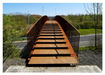
Structurellement, un caisson de 200 x 25 cm appuyé aux extrémités et à mi-longueur franchit des travées de +/- 20 m. L'ensemble des éléments caissons, garde-corps, marches, colonnes d'appui ont tous été réalisés à partir d'un seul coil de 2 m de large et 8 mm d'épaisseur déroulé avant d'être découpé par oxycoupage.
