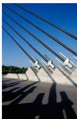
0-COINTE Bossages d'ancrages des haubans de la culée d'équilibrage du pont de Laroze.
