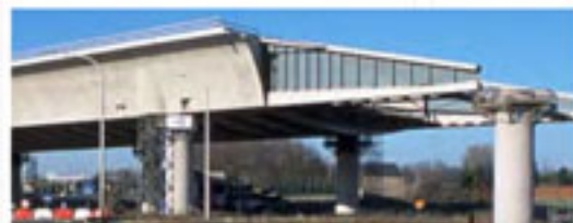
0-COINTE L'accostage de l'avant-bec sur la pile suivante du pont-canal de Houdebeg Algérie
