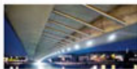
0-COINTE Les bracs du tablier du pont de Liège
